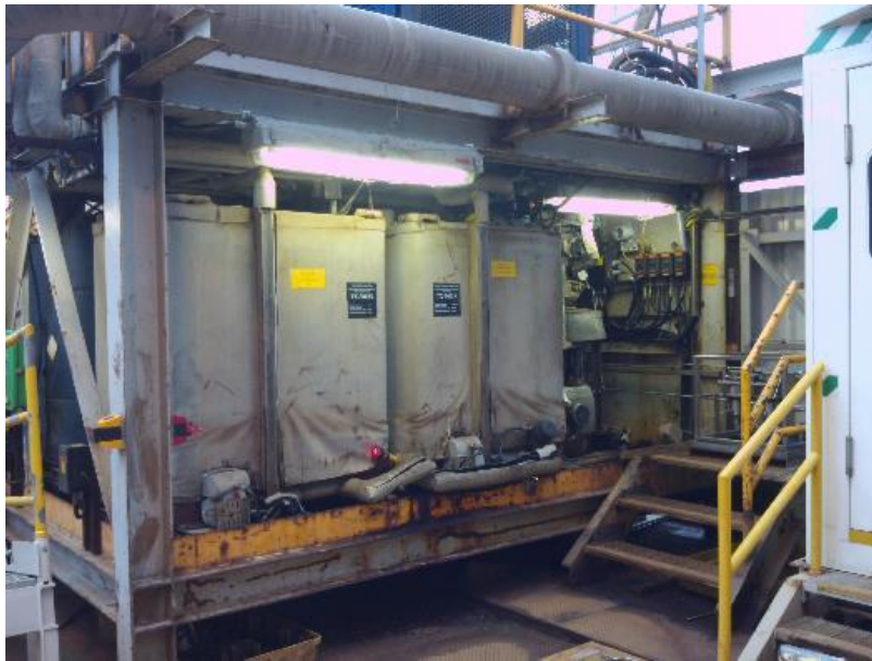
Фото 4. Узел закачки химических веществ (планируется реконструкция вторичной системы локализации).
