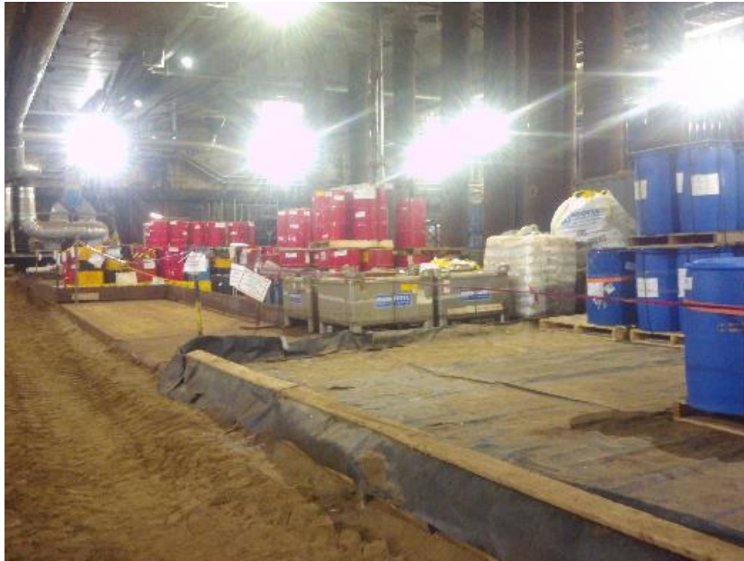
Фото 5. Временная вторичная система локализации для хранилища химических веществ в ядре (планируется модернизация).
