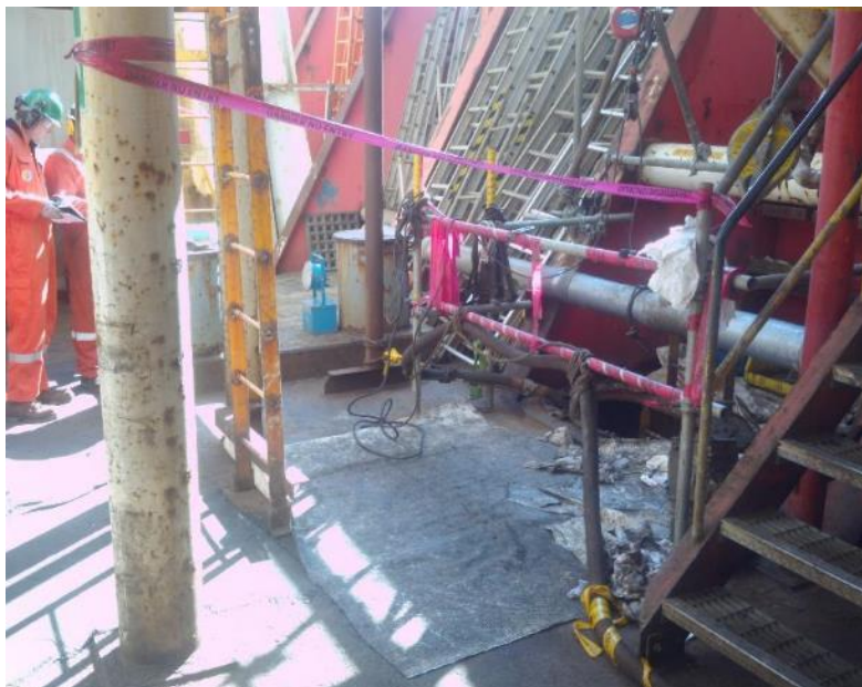
Фото 8. Огражденная зона для работ по очистке и инспекции резервуара БРУО (отмечены опасности спотыкания — временный шланг и абсорбирующий коврик).
