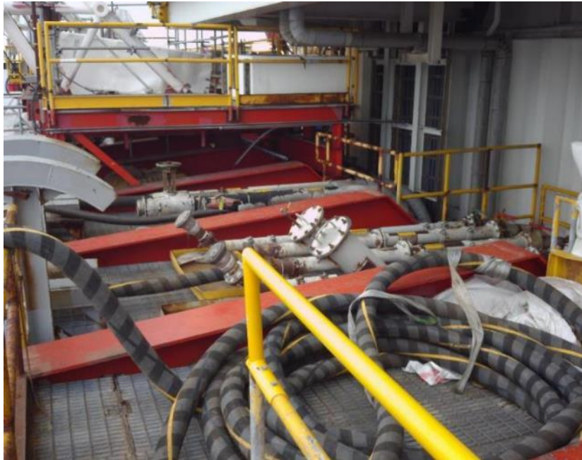
Фото 7. Точка бункеровки для дизельного топлива и БРУО (оснащена вторичной системой локализации и поддонами).
