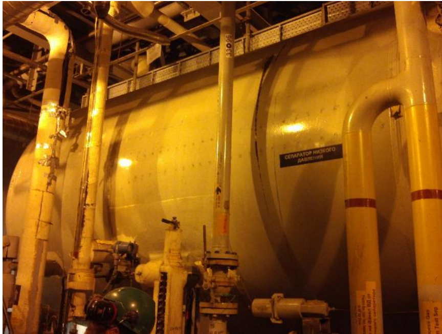
Фото 9. Сепаратор низкого давления в технологическом модуле (часть трехфазного процесса).
