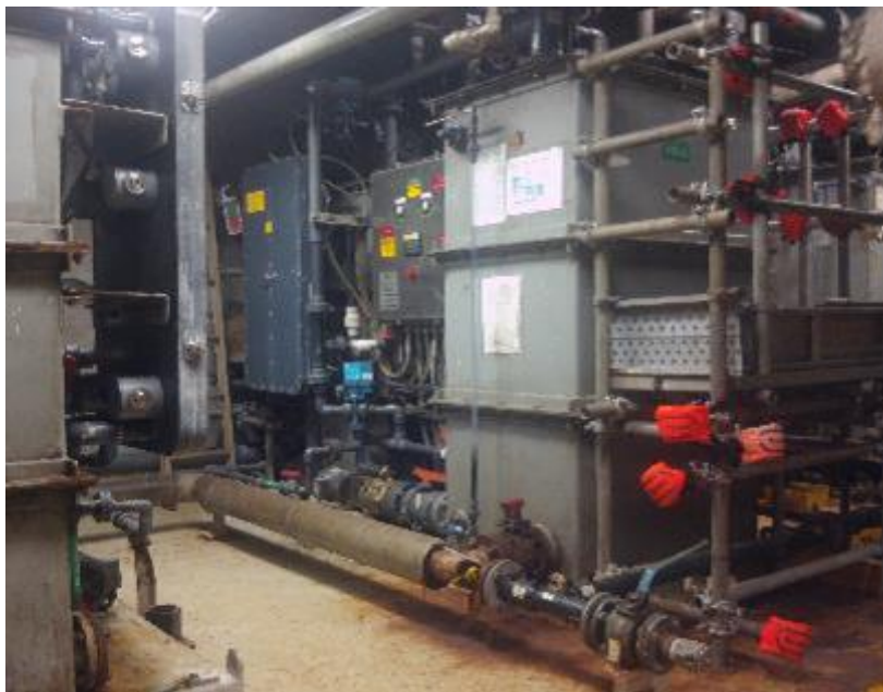
Фото 6. Установка очистки сточных вод (один из трех блоков на борту ПА-А).
